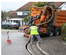
Grabenfräsen und Aushub absaugen
