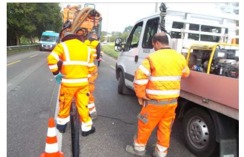
3. Verlegen des Rohres
