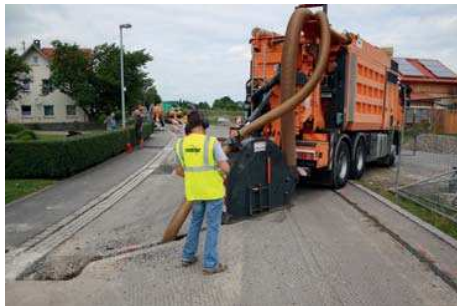
1. Ansetzen für Hausanschlüsse
